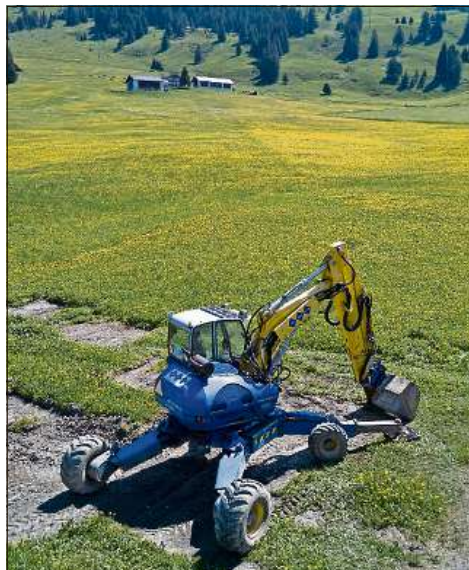
Das neue Gebäude entsteht unterhalb der Alpkäserei am Parkplatz Heimberg. Bild Nicole Trucksess
